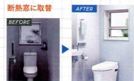
古くなったルーバー窓を上げ下げ窓に取替えて、すきま風の悩みを解消。冬の寒さも軽減。
